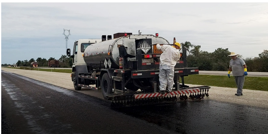
Serviços de imprimação do pavimento no Lote 5
