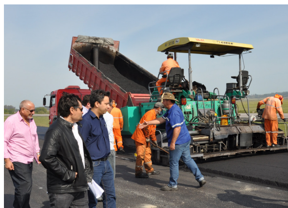
No Lote 9 devem ser liberados 15 km de pista em março de 2018
