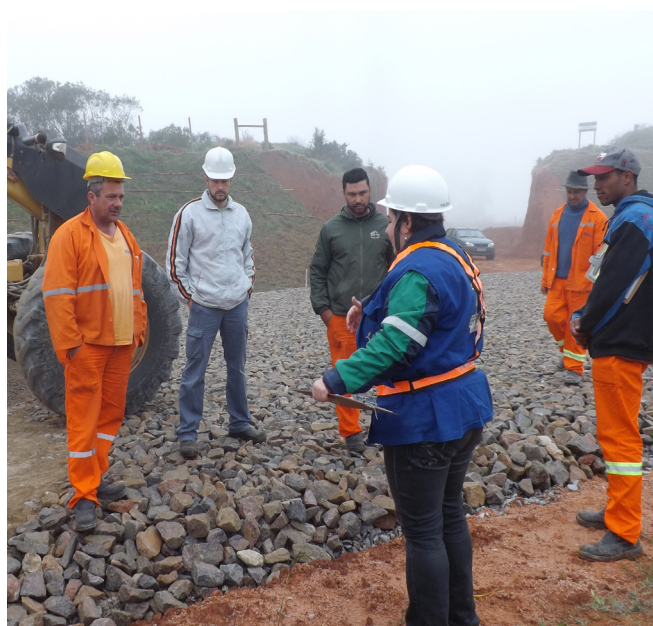
No Lote 7 conversas sobre segurança no trabalho foram nas frentes de obra
