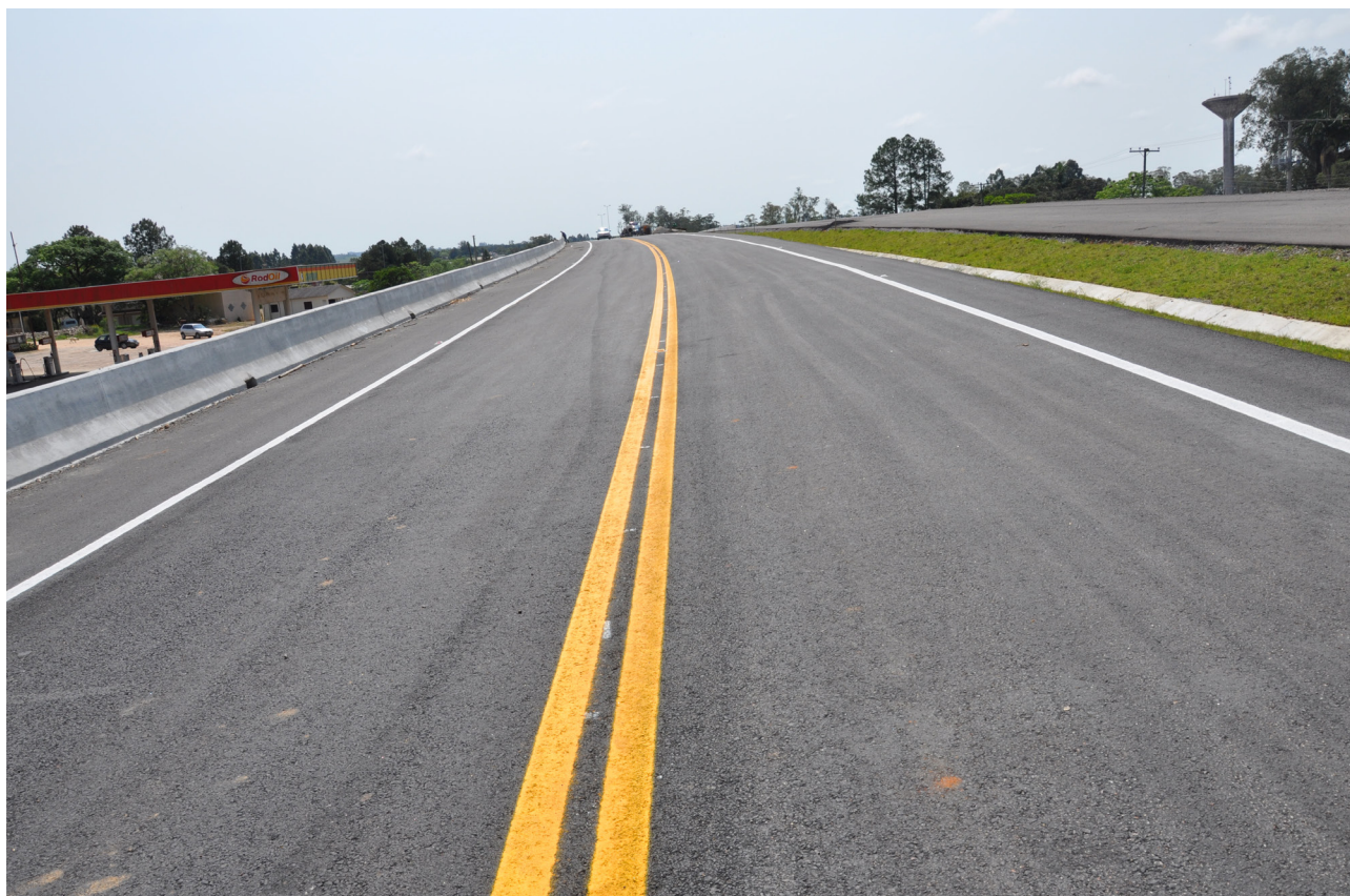
Estrutura em operação desde o dia 26 de setembro; DNIT/RS liberou apenas a pista coincidente com a pista existente
