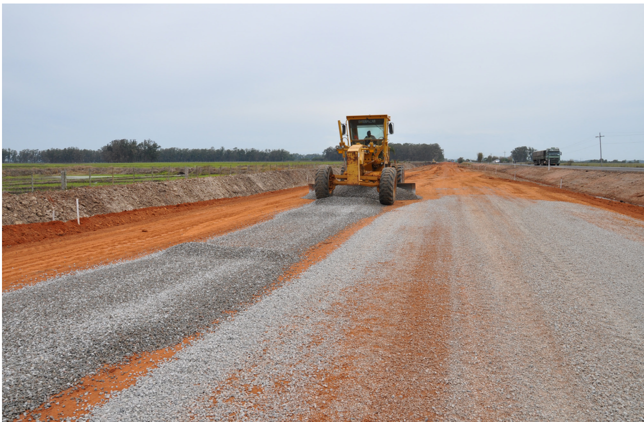
O bloqueio da terraplenagem é a etapa que antecede a execução da primeira camada de pedra do pavimento, denominada de macadame seco
