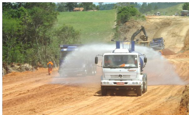
Umidificação das vias e frentes de obra é uma das medidas mitigadoras
