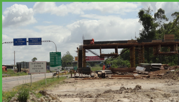
Desvio é necessário para execução e escoramento das vigas do viaduto
