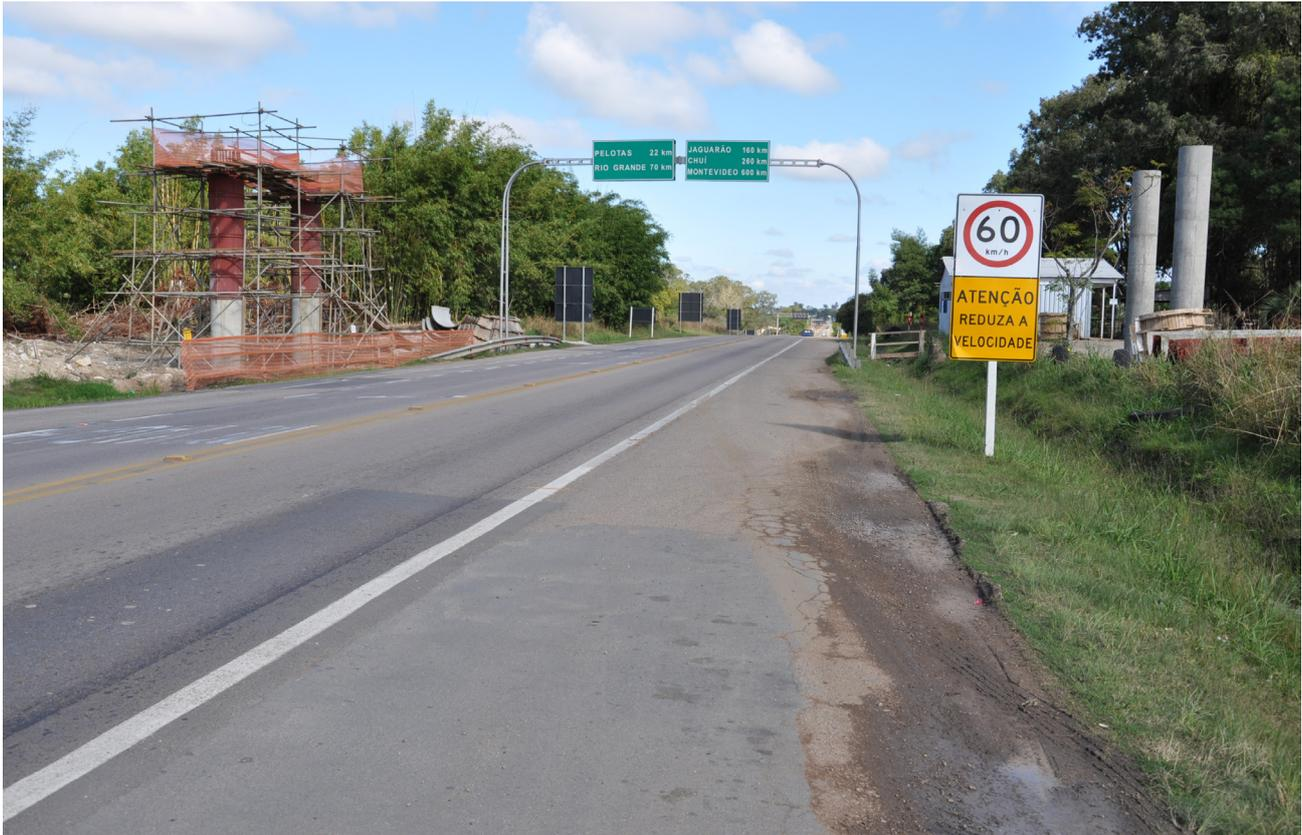
Construção do viaduto está nas etapas de fundações e infraestrutura (pilares), fases que antecedem a mesoestrutura (vigas) e a superestrutura (tabuleiros)
