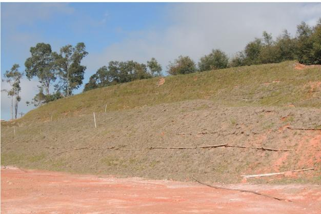
Taludes da EC-10, no lote 06, foram conformados e revegetados com leivas
